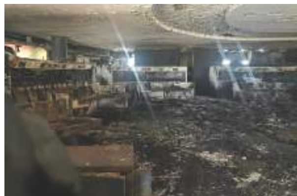
RESTOS del Centro de Control del STC, ayer, tras el incendio.
