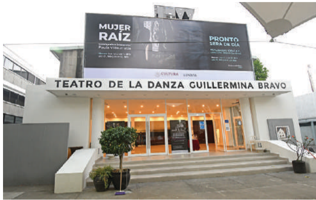
En el Teatro de la Danza se cambiaron las luminarias y muros de áreas comunes.
