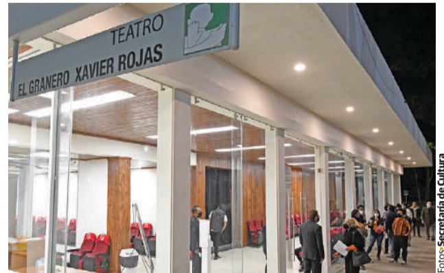
En el Teatro El Granero se cambió la fachada por muros de cristal templado para mejorar la iluminación.
