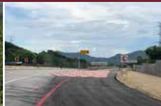
Construcción de Rampa de Emergencia
