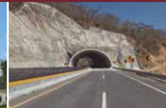
Túnel "Puerta Costa Grande" Terminado
