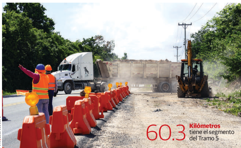
OBRAS en el tramo 5 del Tren Maya, el pasado 21 de julio.
