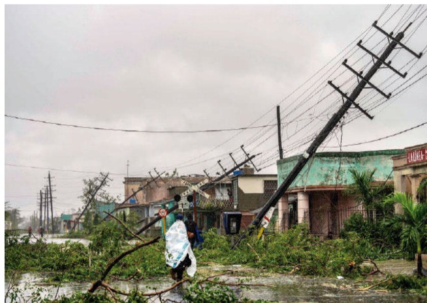
RESIDENTES avanzan entre infraestructura derribada por los fuertes vientos, ayer.
