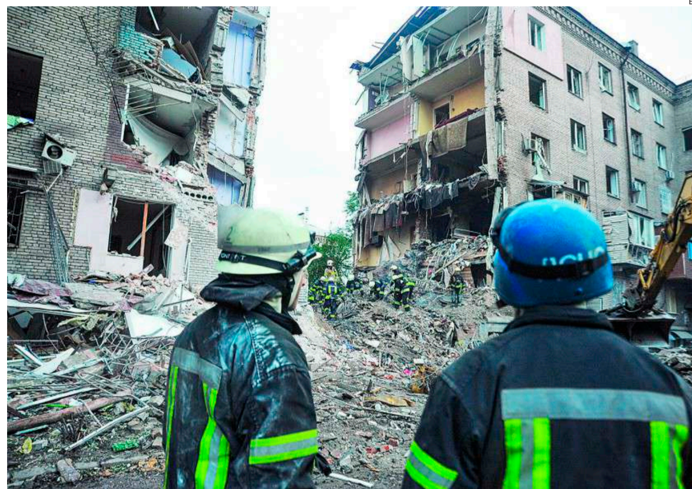
Los servicios de rescate ucranianos buscan a supervivientes en un edificio alcanzado por un misil ruso en Zaporizhzhia
