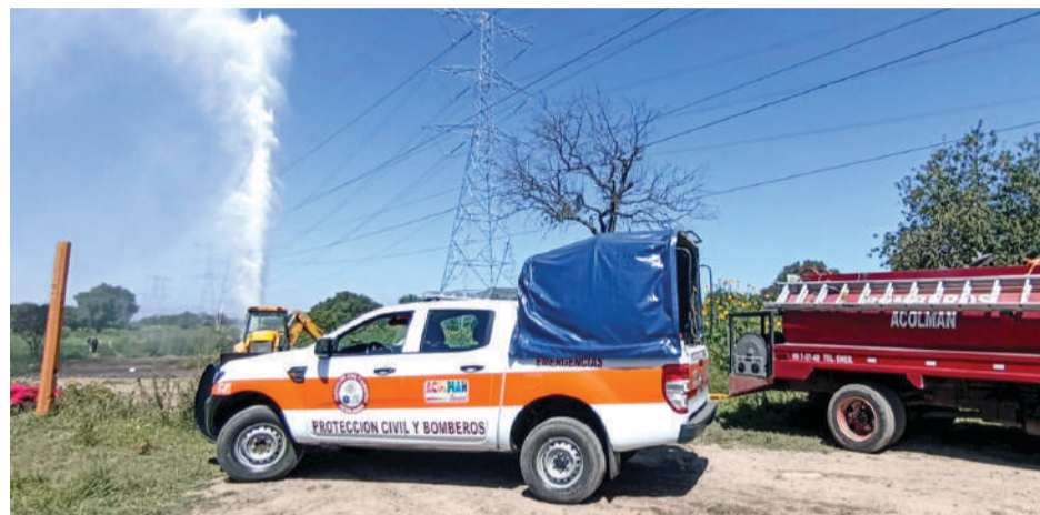
FUGA en un ducto de Pemex por una toma clandestina, en Acolman, en agosto de 2021.
