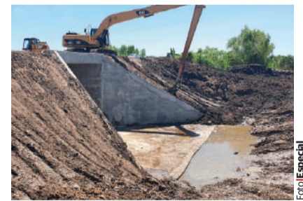
AVANCE de la obra del Libramiento de Villahermosa, en imagen de archivo.
