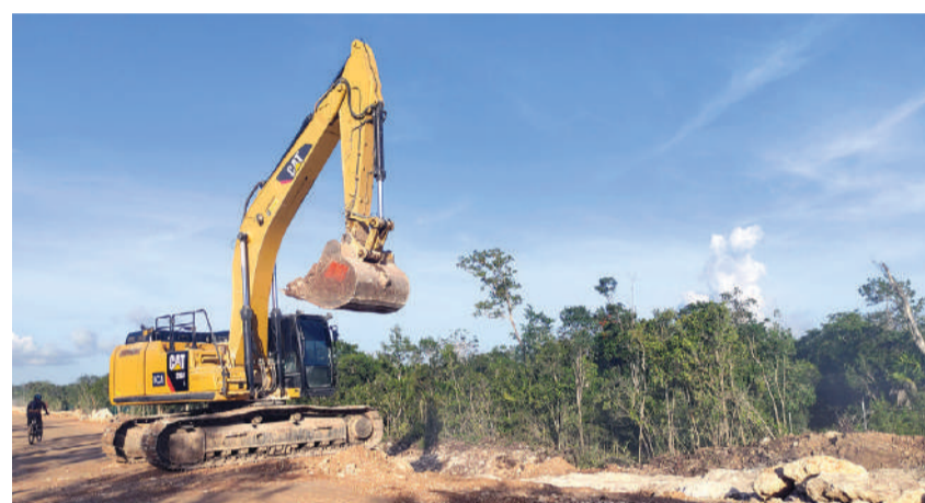
MAQUINARIA pesada trabaja en el Tramo 5 Norte, el pasado 27 de noviembre.
