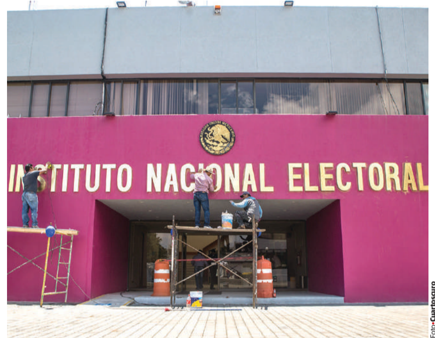
FACHADA de la sede principal del INE, durante una remodelación, en junio de 2018.
