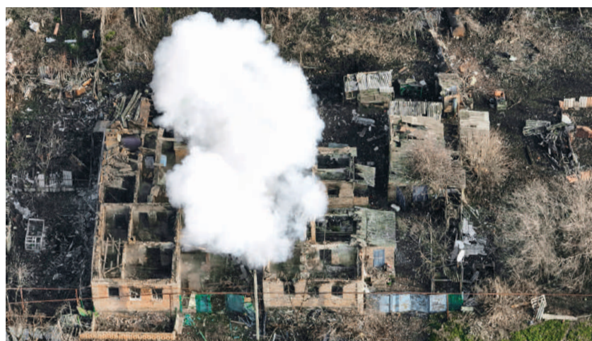
DEFENSORES MUESTRAN el daño ocasionado por bombardeos en Bajmut, ayer.
