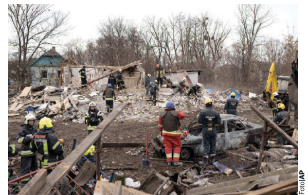
PERSONAL DE EMERGENCIA retira escombros de una vivienda destruida en la capital, ayer.
