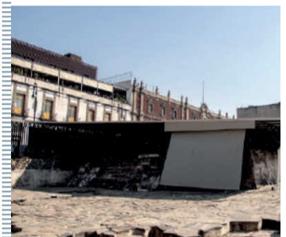
ESTRENO EN TEMPLO MAYOR. Después de un año y siete meses de que colapsó la techumbre que protegía la Casa de las Águilas, el pasado 15 de noviembre se volvió a abrir esta zona con una nueva cubierta más ligera, más amplia y con un tiempo de vida útil de entre 10 a 15 años, se detalló.
