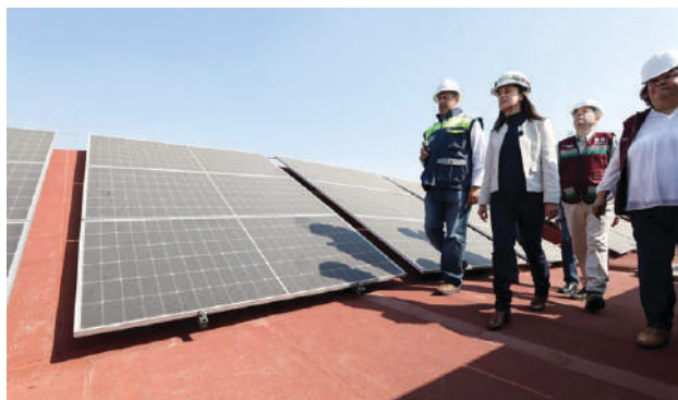
LA MANDATARIA CAPITALINA, durante el recorrido que realizó por la planta fotovoltaica de la Central de Abasto, ayer.
