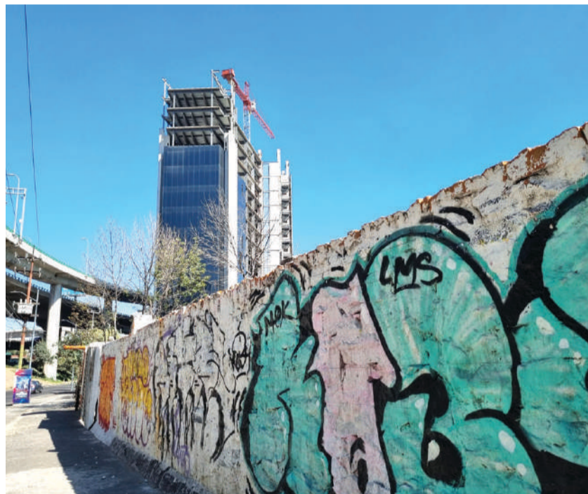
EN LAS CERCANÍAS de donde se construye el desarrollo inmobiliario hay otras edificaciones de varios niveles, que están suspendidas desde hace varios años.
