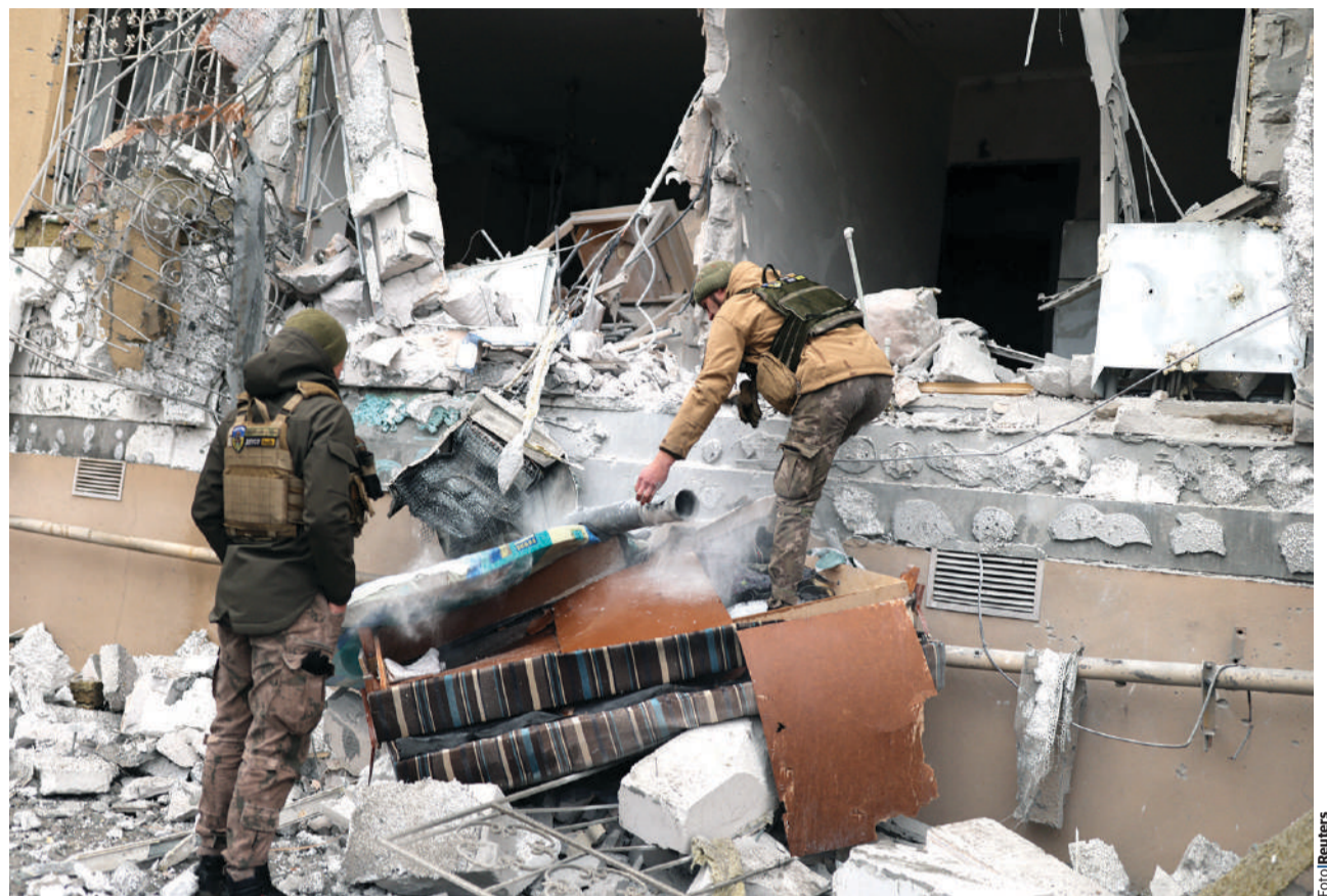
ELEMENTOS DE EMERGENCIAS en Ucrania inspeccionan un inmueble bombardeado en Jerson, ayer.
