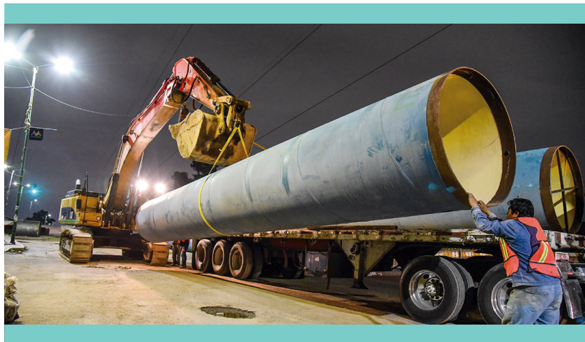
CON APOYO de una excavadora, trabajadores descargan una tubería de acero.
