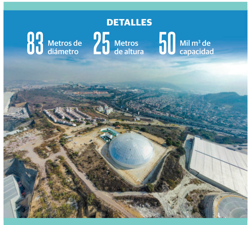
EN LA IMAGEN panorámica, el depósito ubicado en Cuautitlán Izcalli.
