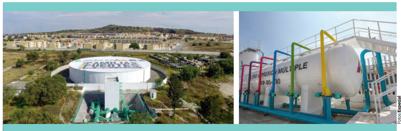
A LA IZQ. EL TANQUE de almacenamiento de agua potable, en Huixquilucan, y a la der. la red hidráulica de Nezahualcóyotl.
