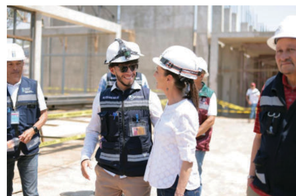
LA JEFA DE GOBIERNO, Claudia Sheinbaum, durante su recorrido por las obras de la Cuarta Sección de Chapultepec, ayer.
