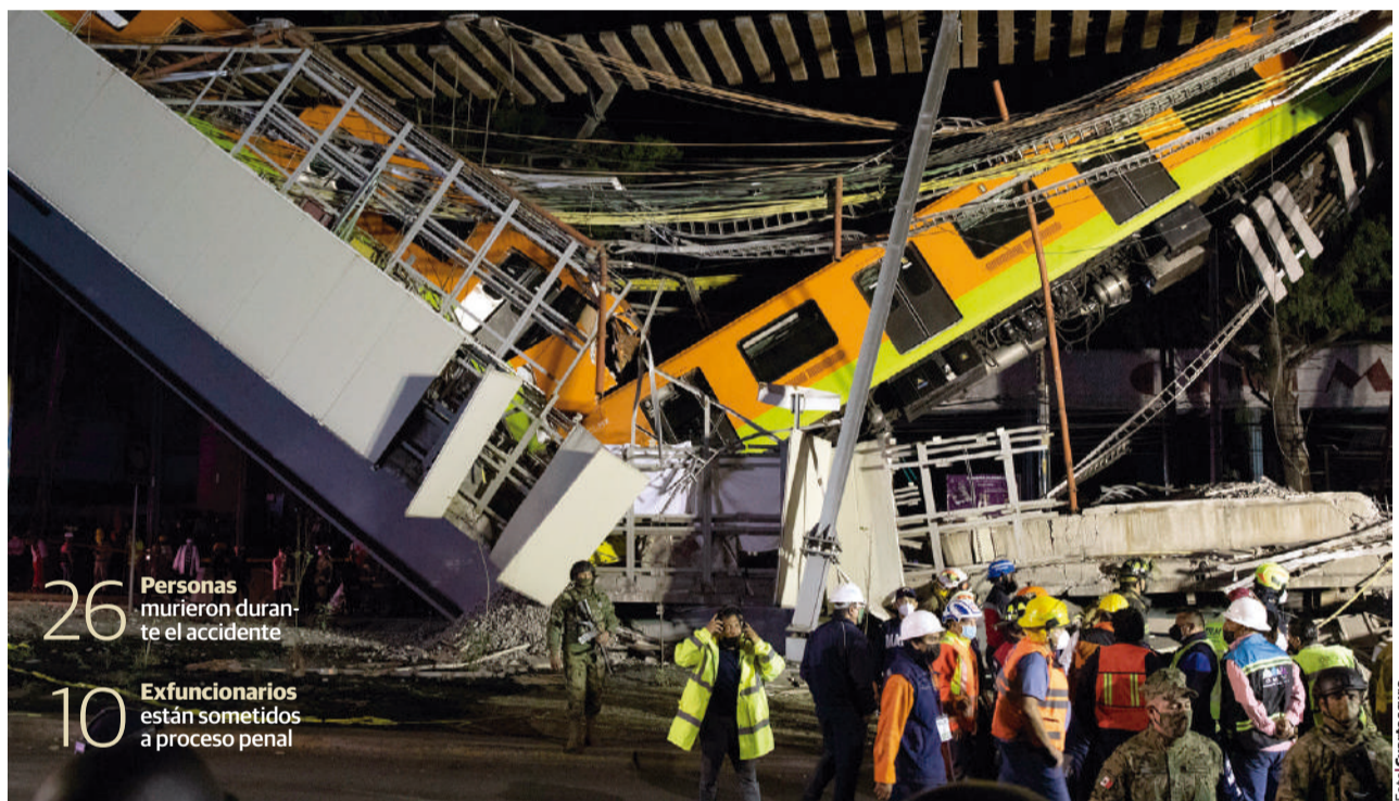
EL 3 DE MAYO del 2021 se desplomó una parte del tramo elevado de la Línea 12 del Metro, cerca de la estación Olivos.
