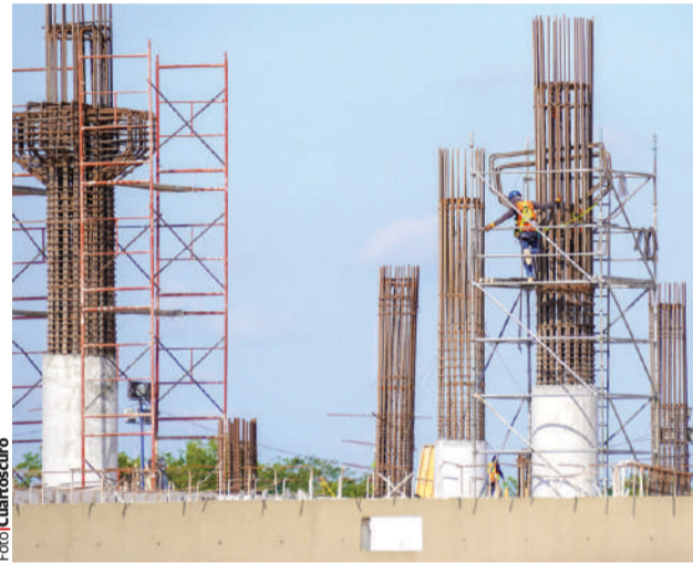
CONSTRUCCIÓN de la estación del Tren Maya en Cancún, ayer.
