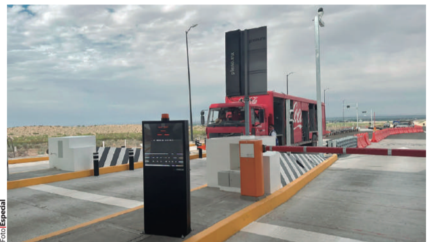
CASETAS del nuevo libramiento carretero ubicado en Ciudad Juárez, Chihuahua, ayer.
