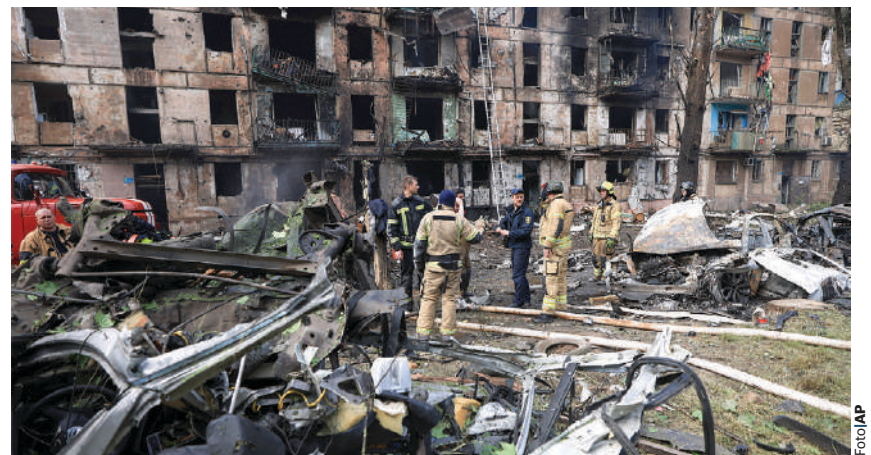
RESCATISTAS evalúan el daño en el edificio de departamentos alcanzado por un misil.
