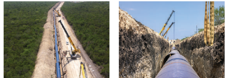
AVANCES en la construcción del Acueducto El Cuchillo.
