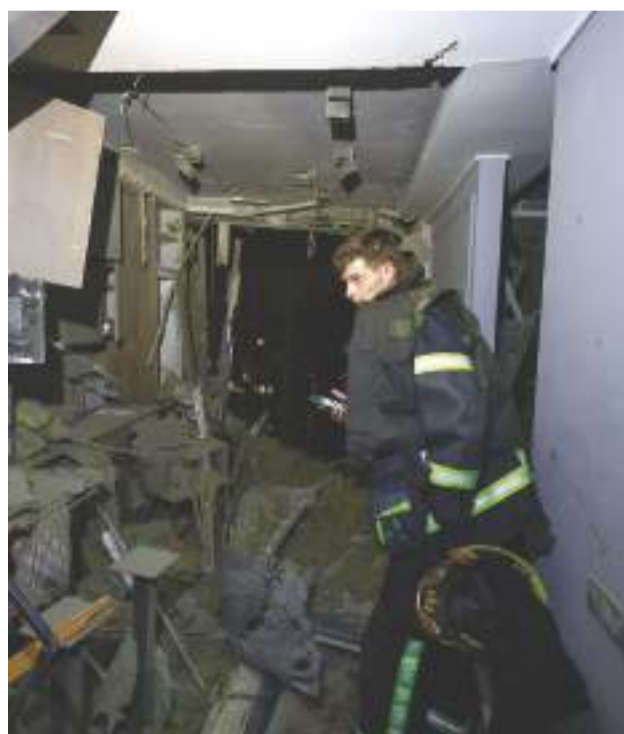
UN RESCATISTA inspecciona un apartamento dañado durante un ataque con drones rusos en Kiev, Ucrania, ayer.
