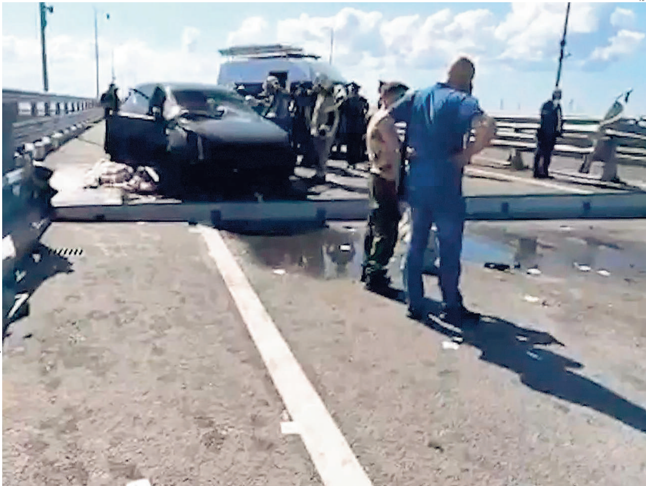
Imagen de un vídeo en el que se puede ver los daños del puente de Kerch tras la explosión de drones marinos, ayer
