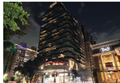
EL CITY TOWER, edificio señalado por irregularidades, en imagen captada ayer.
