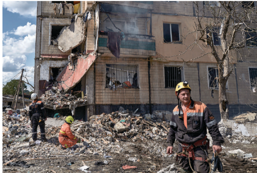
ELEMENTOS DEL SERVICIO ESTATAL de Emergencia nacional inspecciona la zona afectada por el impacto de un misil, ayer, en Krivói Rog.
