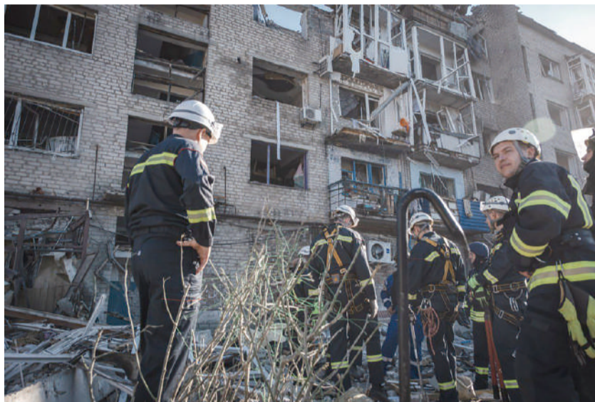
PERSONAL DE EMERGENCIAS Y BOMBEROS se preparan para inspeccionar un edificio residencial impactado por un misil, ayer.
