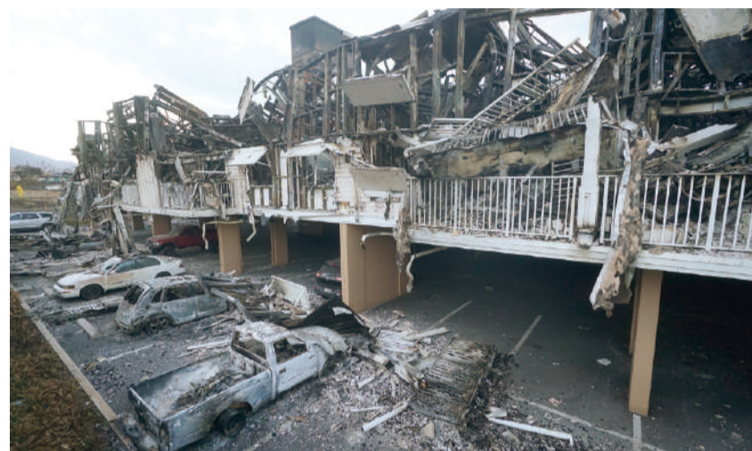
UN EDIFICIO residencial y vehículos dañados tras el incendio en Lahaina, ayer.
