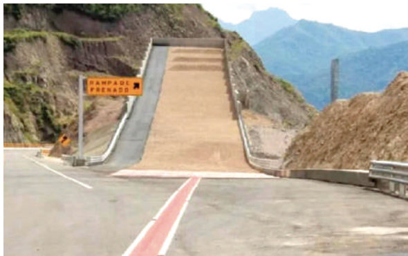
LAS RAMPAS de frenado se encuentran en las diversas carreteras federales del país para evitar accidentes.
