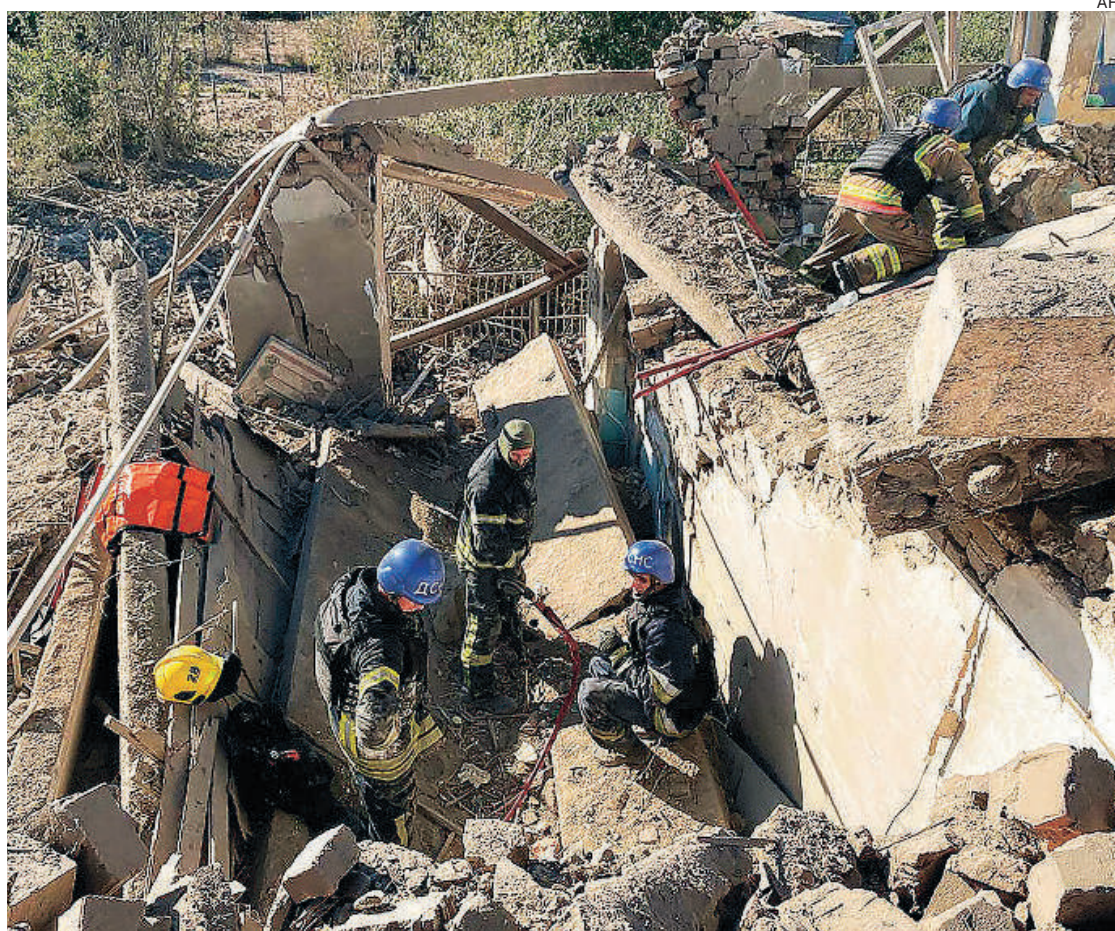
Miembros del servicio de emergencia de Ucrania en un edificio bombardeado en Nikopol
