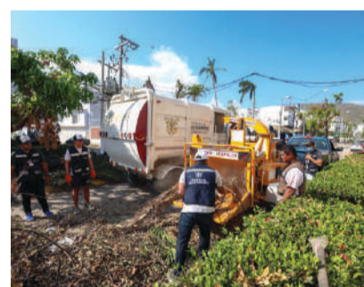
TRABAJOS de limpieza continúan en la zona afectada por Otis.
