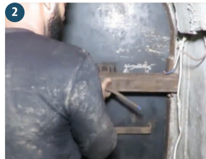
2 AL INTERIOR de ese sistema avanzado hallan puertas blindadas.
