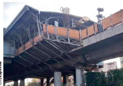
PARTE DEL TRAMO de la LB que será renivelado, según lo informado ayer.
