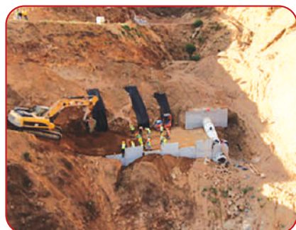
Tramo 2 Del kilómetro 135 al kilómetro 154+000.
