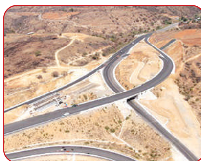
Tramo 1 Del kilómetro 100+000 al kilómetro 135+000.
