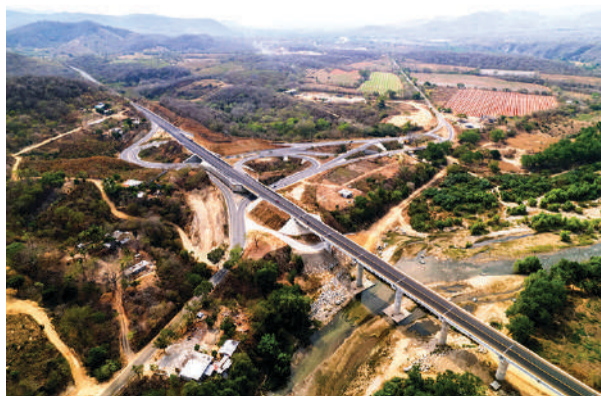
EL TRAMO carretero Barranca Larga-Ventanilla.
