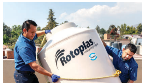
EMPLEADOS de la empresa durante la colocación de un tinaco.
