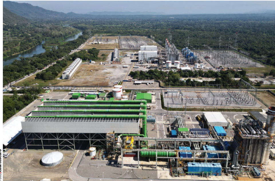
EL PASADO martes, el Presidente López Obrador encabezó en Tamazunchale, San Luis Potosí, la puesta en operación de 13 centrales de energía eléctrica, adquiridas a Iberdrola.
