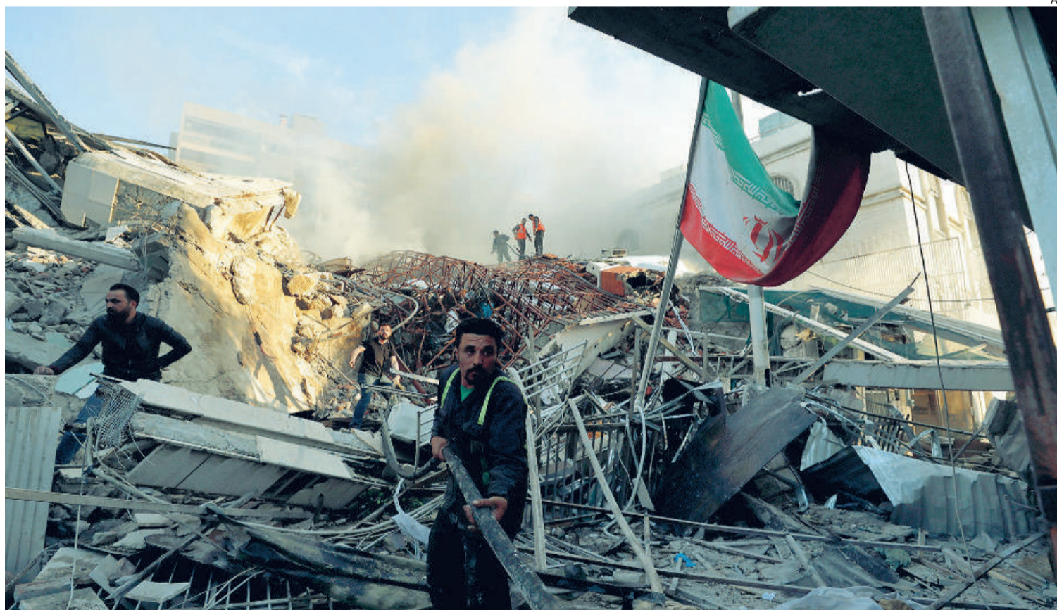
Servicios de emergencia sirios trabajan entre los escombros de la zona consular de la Embajada de Irán en Damasco
