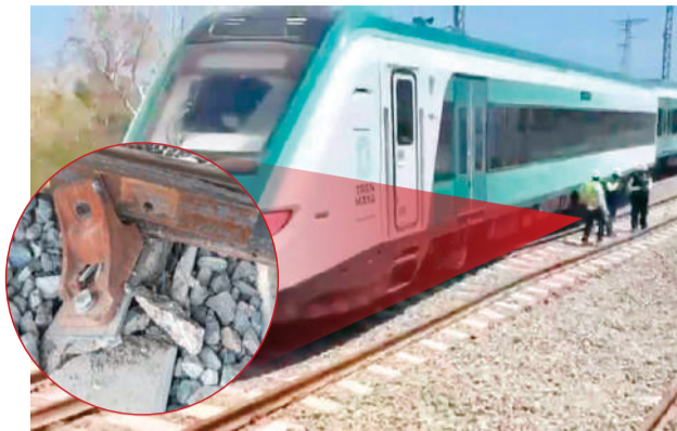
FIJADOR (CLAP) roto en vías del Tren Maya tras el accidente del pasado 25 de marzo.
