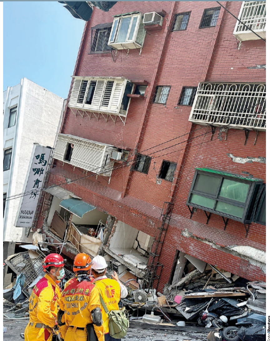
BOMBEROS trabajan en el lugar donde colapsó un edificio, ayer en Hualien.
