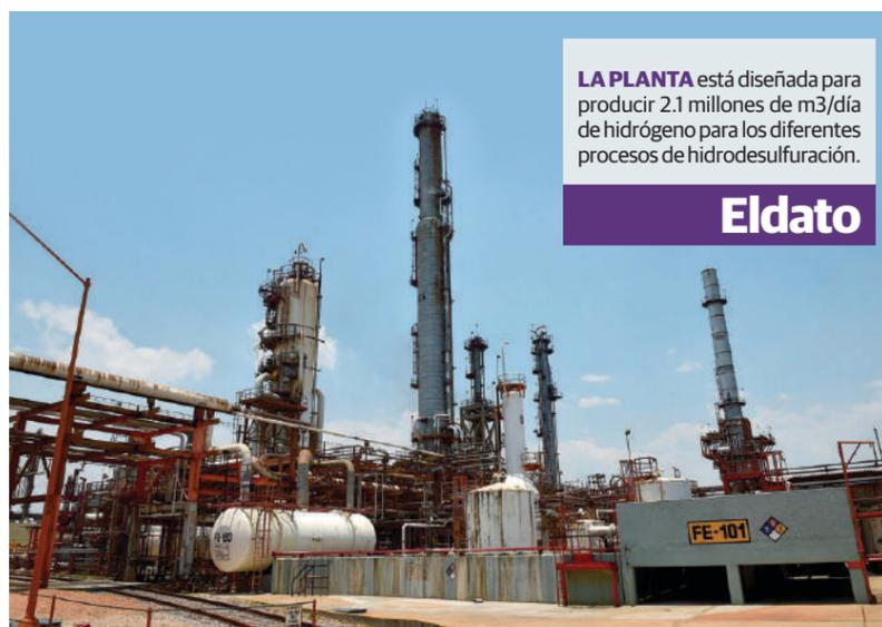
LA PLANTA está diseñada para producir 2.1 millones de m3/día de hidrógeno para los diferentes procesos de hidrodesulfuración.
