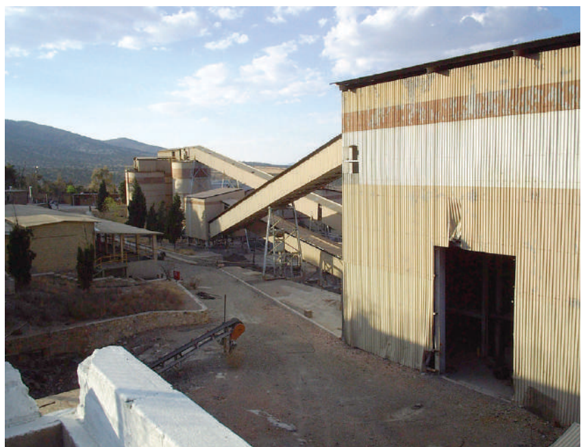
LA MINA SAN MARTÍN, está ubicada en Sombrerete, Zacatecas.
