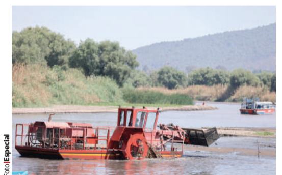
HABITANTES de Pátzcuaro al realizar trabajos de desazolve, ayer.
