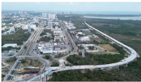
EL PUENTE reducirá el tiempo entre el aeropuerto de Cancún y la zona hotelera.
