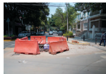
ASPECTO de la obra inconclusa en la lateral de Río San Joaquín.
